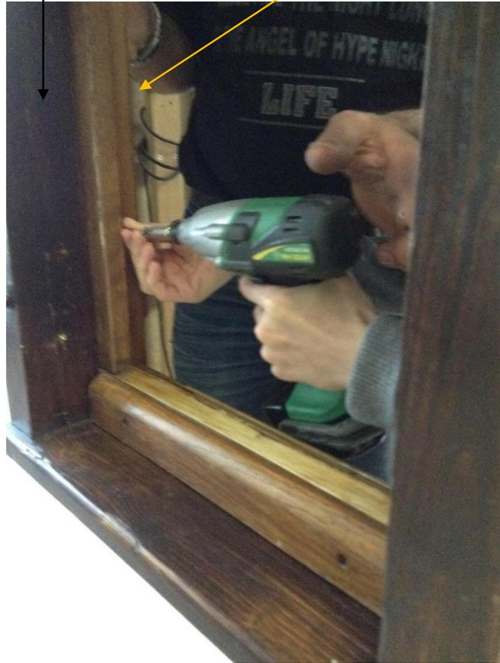
Allan installe le volet sur l'encadrement de fenêtre
